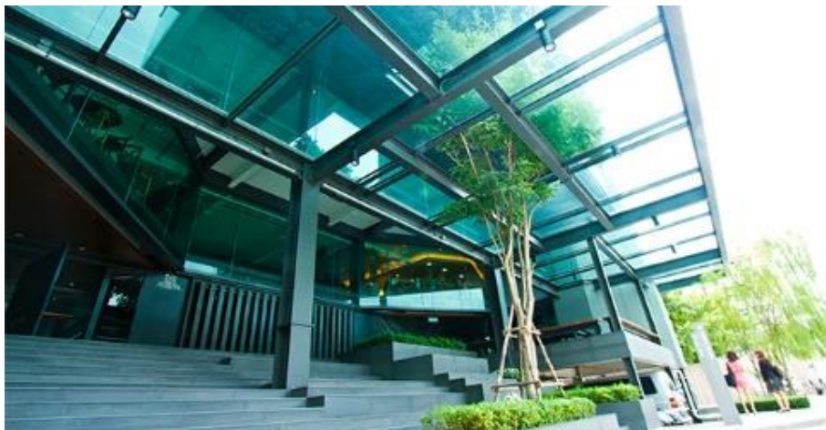
รูปที่ 7 การใช้งานผลิตภัณฑ์เหล็กโครงสร้างรูปพรรณรีดร้อน รูปตัวเอช (H beam) ในงานโครงสร้าง ที่มา : https://www.syssteel.com/product/?type=1#sys-products
